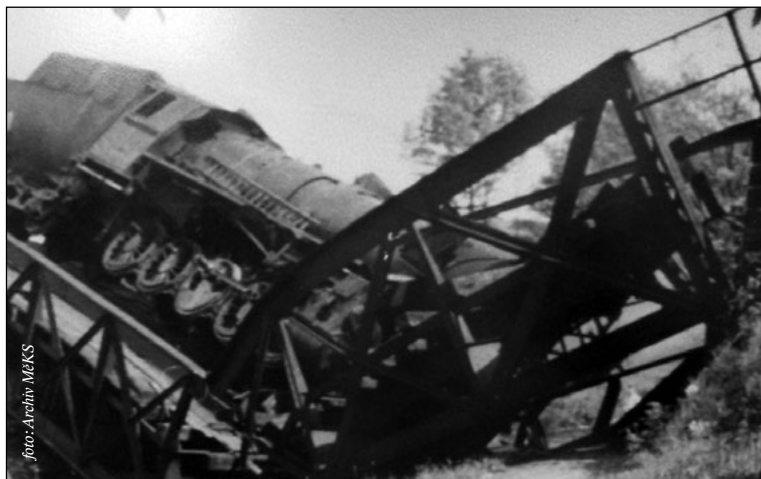
Lokomotiva na Němci odstřeleném mostě přes Lomnou, květen 1945
