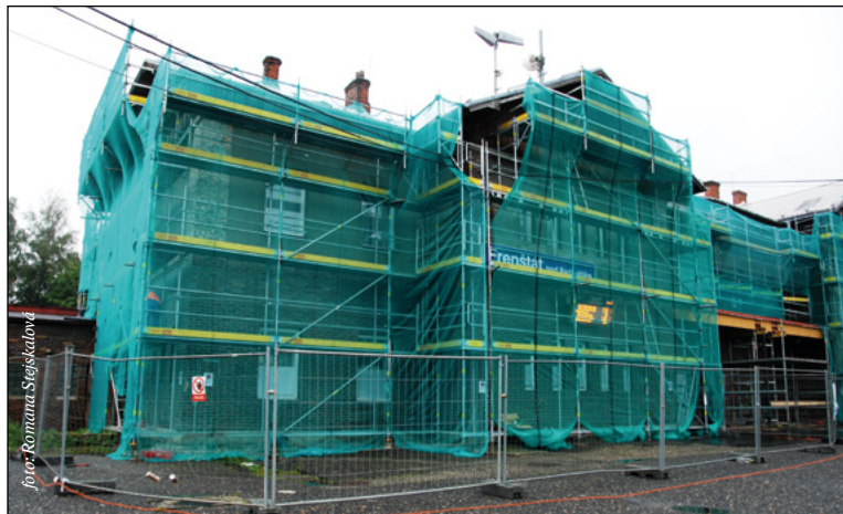
Provoz autobusové dopravy je zachován. Během zimní sezony budou probíhat práce uvnitř budovy
