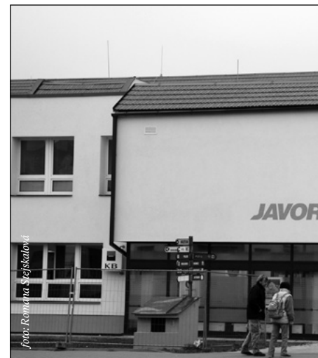
Oprava přístavby radnice je již dokončena
