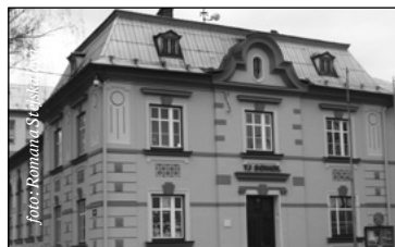
Budovu sokolovny rozsvítila nová fasáda
