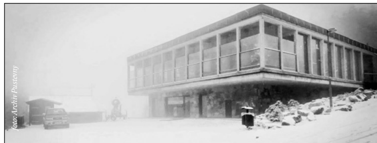
Horní stanice lanové dráhy byla navržena a postavena tak, aby mohla v budoucnu bez dalších zásahů sloužit nové kabinkové lanovce
