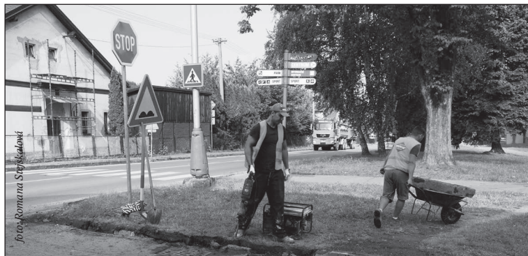
Oprava místní komunikace A. Havleny
