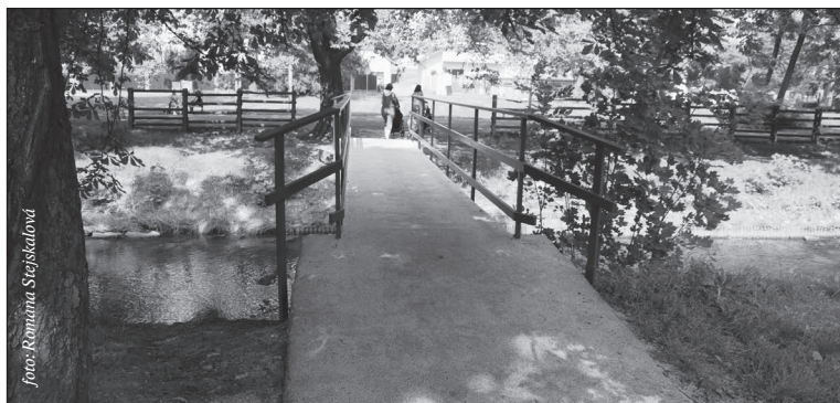
S opravami lávek přes Lomnou se začalo v říjnu loňského roku. Dokončeny byly letos
