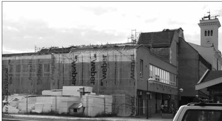
Rekonstrukce byla zahájena na začátku dubna 2018 a bude probíhat do 21. října letošního roku
