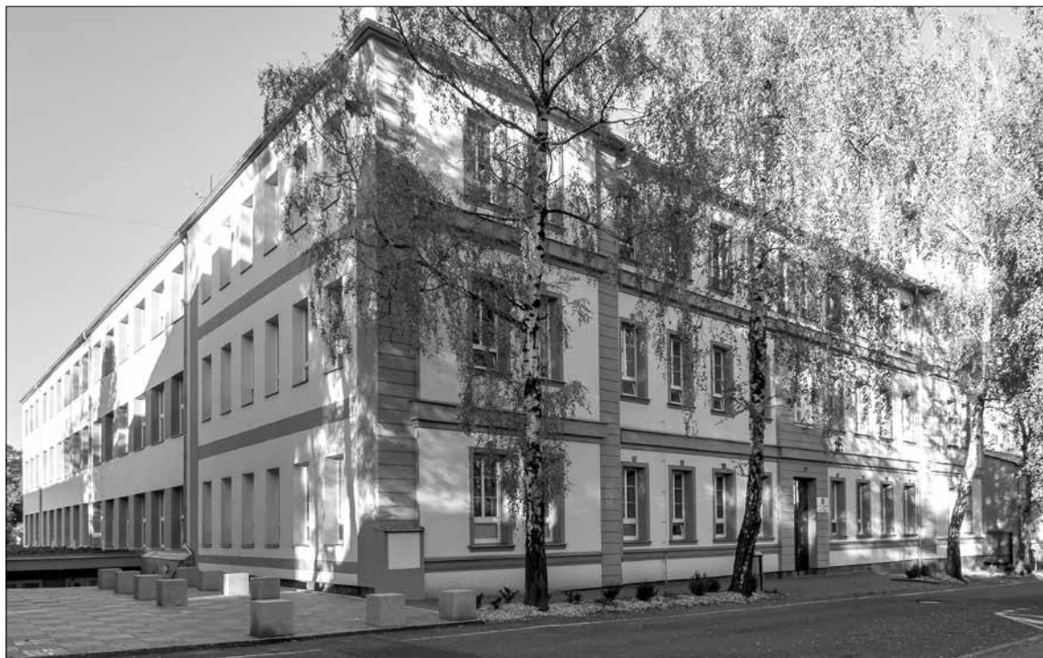
Jednou z největších investičních akcí roku 2017 byla dostavba a rekonstrukce šaten ZŠ Tyršova 913
