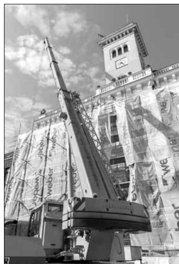
Obnova fasády radnice
