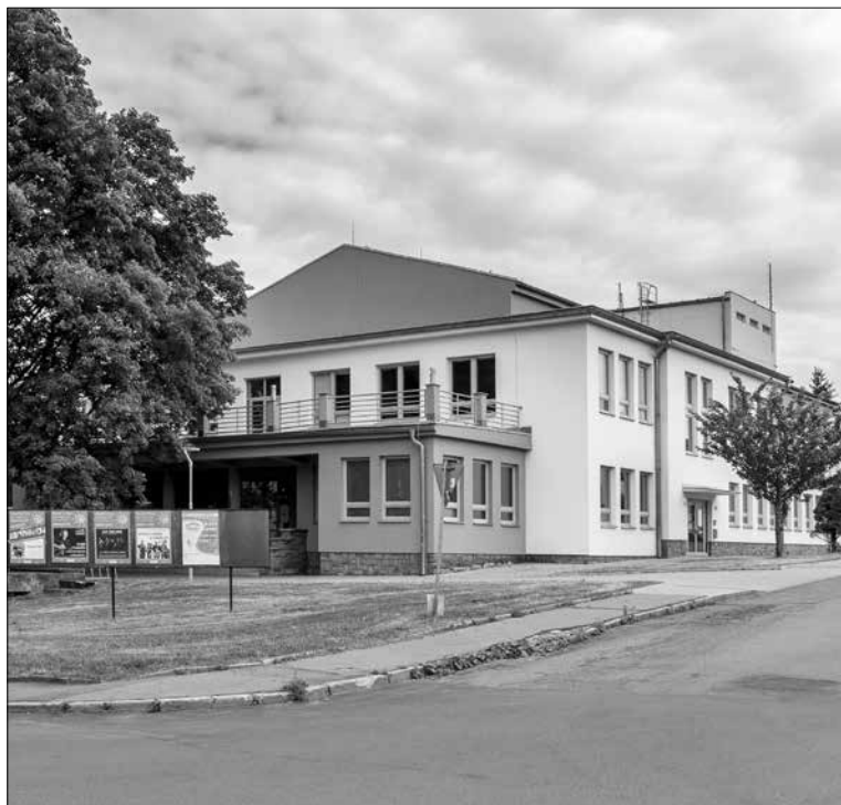
337 dnů trvala rekonstrukce Domu kultury, která stála 68,8 mil. korun
