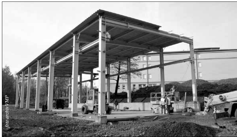
Pod konstrukcí se vestaví jeřáb, udělá se opláštění a vznikne nová hala pro uskladnění velkých stavebních prvků
