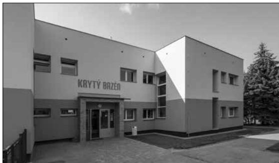
V září 2017 bylo dokončeno zateplení krytého bazénu
