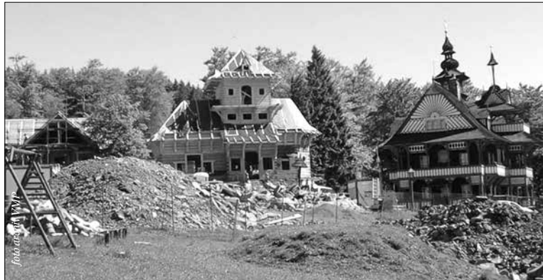
Současná podoba obnovované chaty Libušín na Pustevnách
