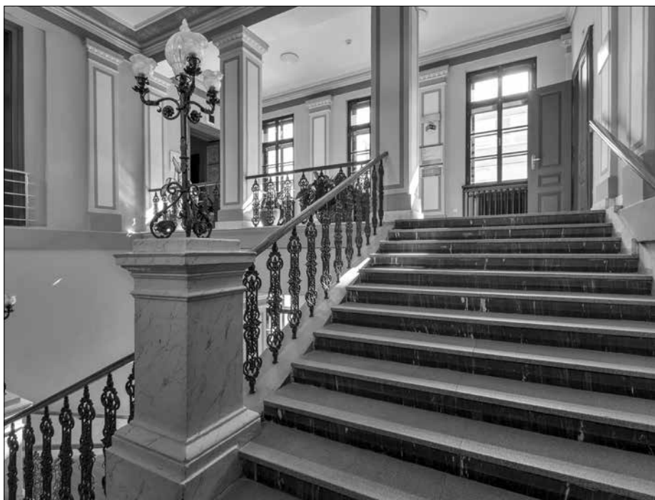
Renovace interiéru v historické části radnice
