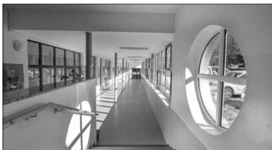
V prosinci 2015 byl na ZŠ Záhumí otevřen spojovací krček, který propojil obě křídla budovy. Pavilon šaten a družinu a školní jídelnu
