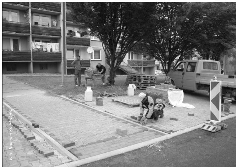
Oprava chodníků a parkovacích stání na ulici A. Havleny
