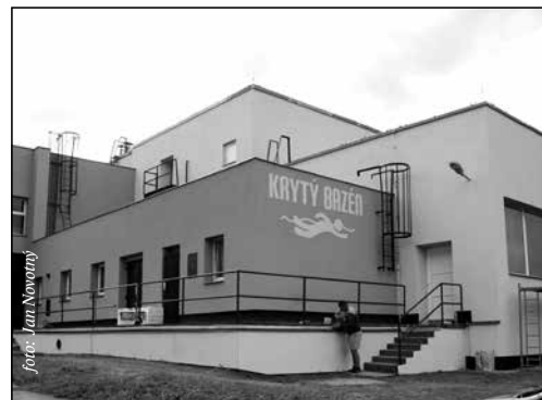
V září 2017 bylo dokončeno zateplení krytého bazénu
