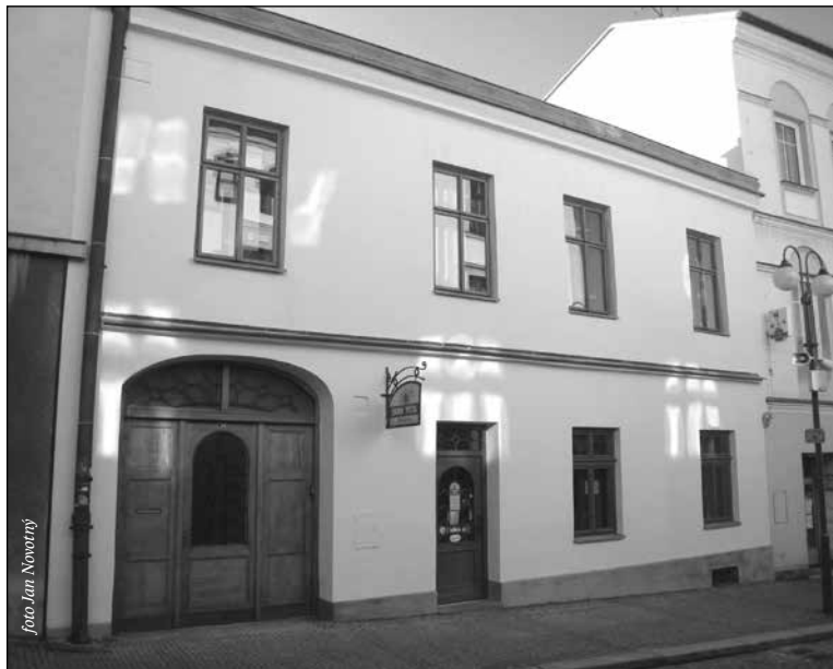
Repase výplní otvorů a obnova fasády 2. n. p. na měšťanském domě č. p. 8
