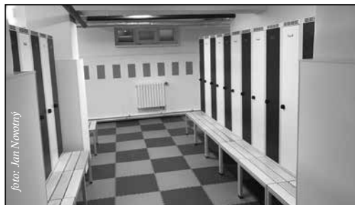
Jednou z největších investičních akcí roku 2017 byla dostavba a rekonstrukce šaten ZŠ Tyršova 913
