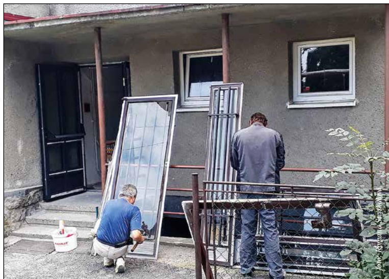
V budově kina byly během prázdnin vyměněny všechny venkovní dveře
