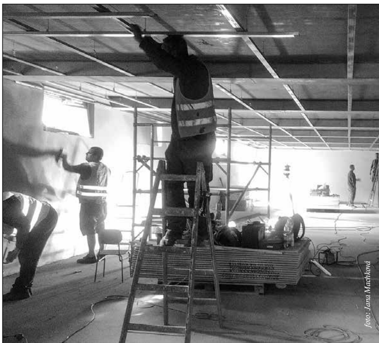
Stavební práce budou ukončeny do 20. září 2017
