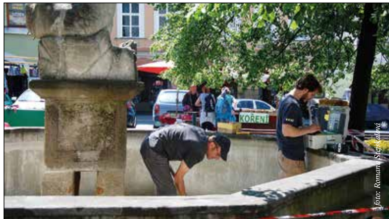
V kašně před jejím napuštěním byla provedena oprava hydroizolace, netěsností a spár
