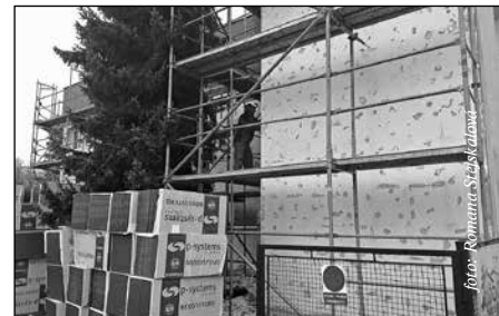
Krytý bazén prochází letos nákladnou rekonstrukcí, která se týká výměny a zateplení obvodového pláště
