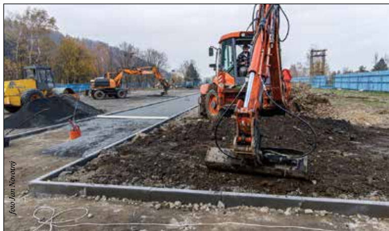
Součástí stavby bude nová technologie chlazení, nové technologické rozvody, parkoviště, zpevněné plochy a osvětlení kolem ledové plochy, k tomu nejnútnejší provozní zázemí pro návštěvníky
