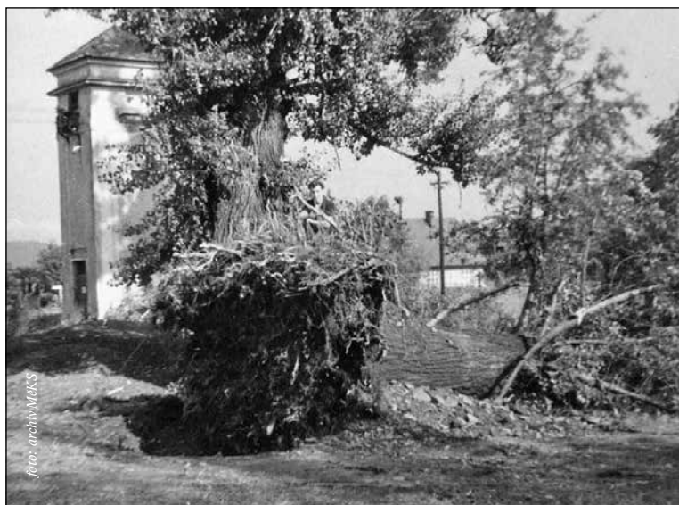
Na tomto snímku leží v popředí bratr topolu černého, jehož torzo bylo pokáceno letos o prázdninách. Za krásnou trafostanicí je skryt starý Tichavský most
