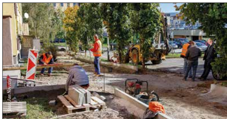
V rámci projektu se vybudují na sídlišti nové chodníky, další parkovací místa a obnoví se kontejnerová stání
