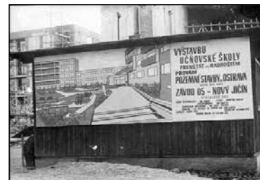
Výstavba učňovské školy na Mariánské ulici (1972 - 1976)
