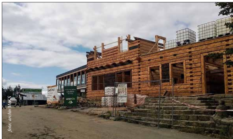
V červnu začala výstavba roubení Libušína. Hrubá stavba by měla stát do konce letošního roku a chata by měla opět začít sloužit na podzim 2019
