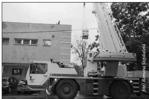
V říjnu byla dokončena oprava střechy frenštátského kina
