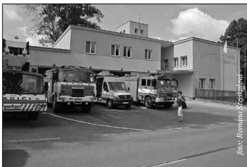
V dubnu 2016 byla hotova přestavba hasičské zbrojnice
