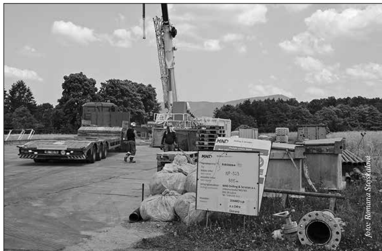
Panelové pracovní plochy pro vrtnou soupravu budou po dokončení prací odstraněny
