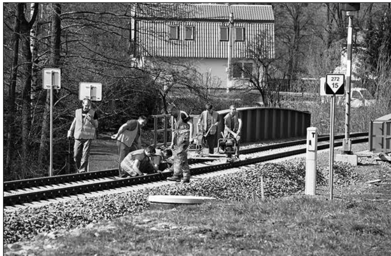
Ze začátkem dubna doladovali dělníci v rámci zkušebního provozu revitalizace železniční trati ČD dílčí stavební úpravy železničních přejezdů ve Frenštátě pod Radhoštěm
