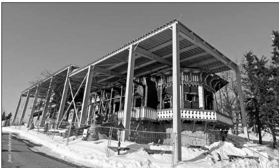
Ocelová konstrukce bude torzo Libušína chránit další rok
