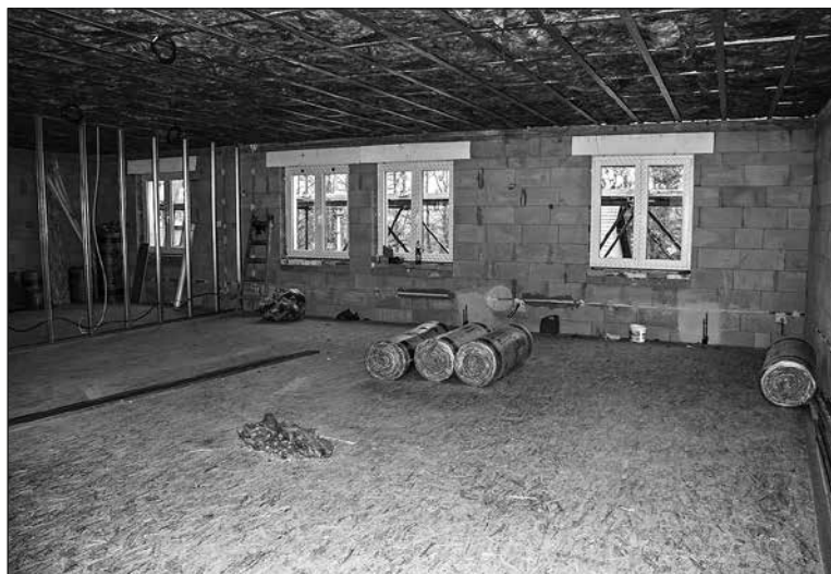
V interiéru se provádí montáž dělicích příček, elektroinstalace a rozvody topení
