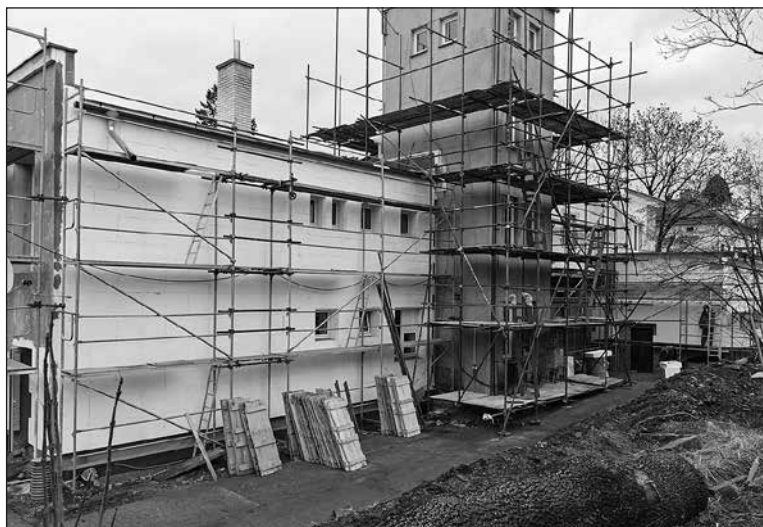
Celý objekt bude zateplen a opatřen novou fasádou
