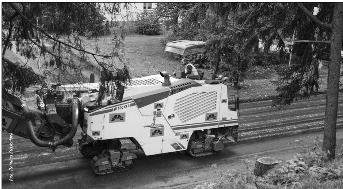
Vedle rozsáhlých oprav komunikace na Záhuní, které zajišťuje kraj, finišují opravy Dvořákovy a Mariánské, které financuje město
