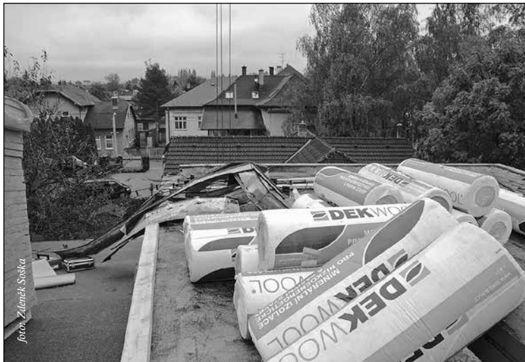
V průběhu října byla opravena střecha frenštátského kina
