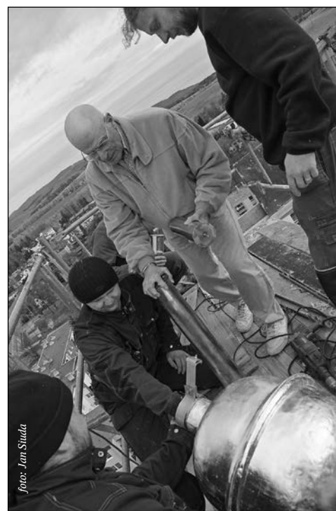
Vkládání tubusů do věže horního kostela
