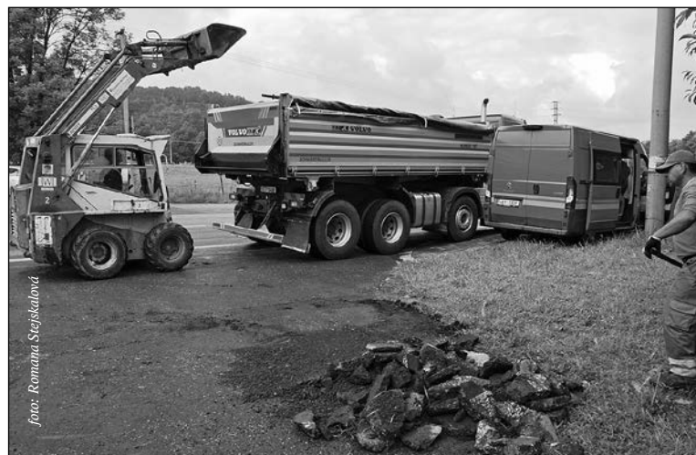
Koncem září byla dokončena oprava komunikace na Papratné
