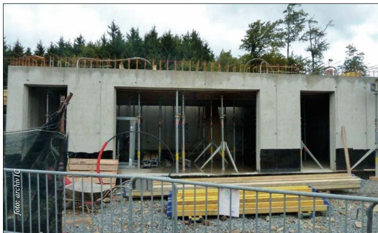
Na Pustevnách se staví horní stanice lanovky
