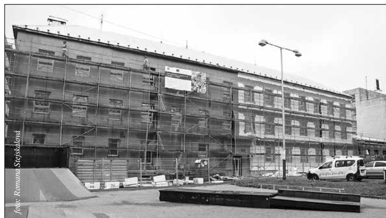
Dokončuje se zateplení obvodových zdí
