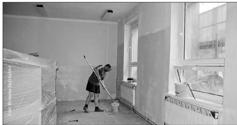
Práce na obnově Astry finišují. Nyní se ke slovu dostali malíři
