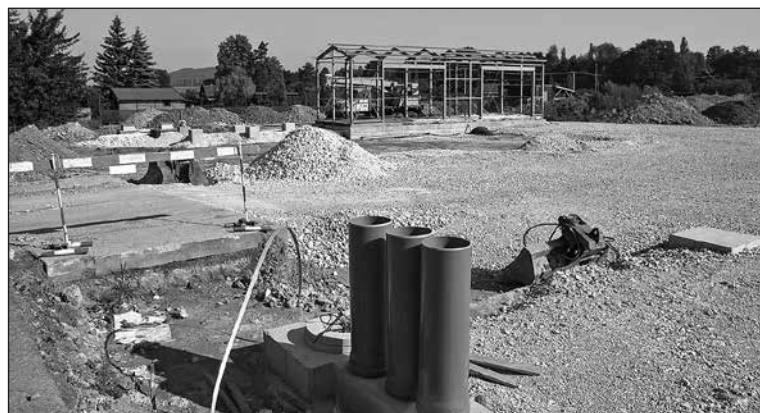
Od poloviny května buduje firma SEWER, s. r. o., Ostrava Sběrný dvůr v areálu Technických služeb. Stavba, na kterou město získalo dotaci od Ministerstva životního prostředí, by měla být hotova v září 2015.
