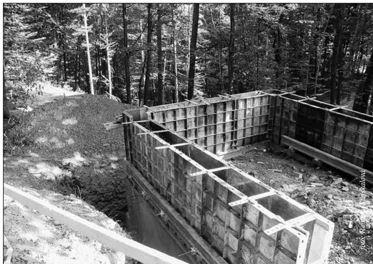
Jsou vybetonovány nástupní a výstupní plošiny budoucí stezky
