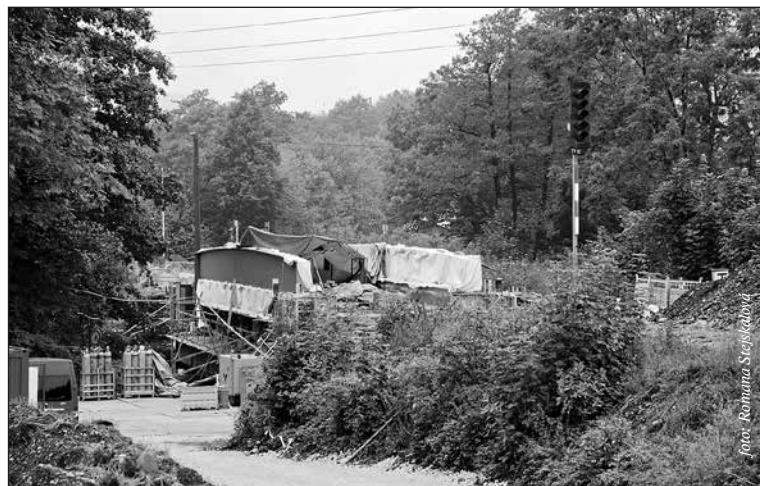
Železniční trať prochází rozsáhlou rekonstrukcí
