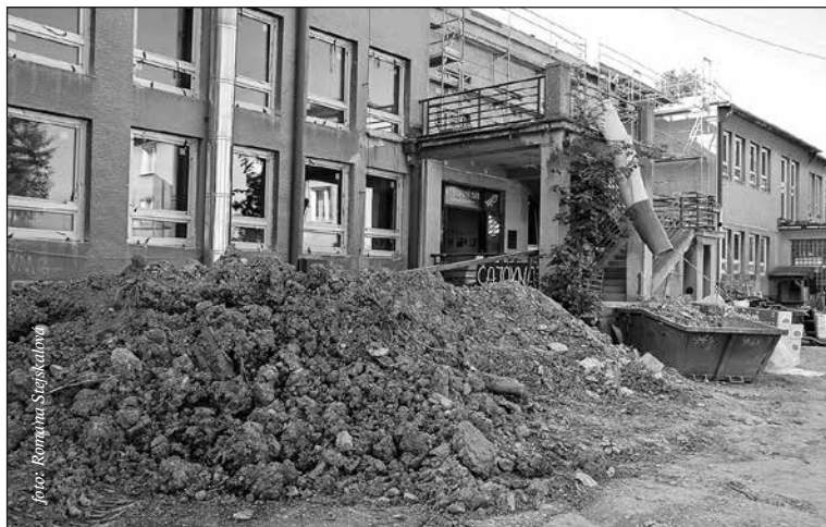
Rekonstrukce Domu kultury. V létě bylo dokončeno odvlhčení budovy pomocí drenáží
