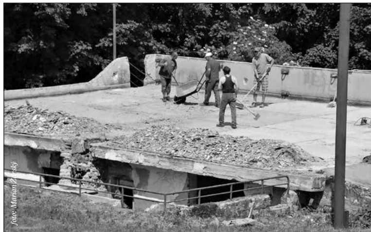
Duben 2012 - rekonstrukce pódia
