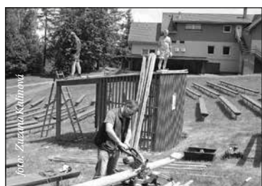
Květen 2014 - stavba zázemí pro zvukaře
