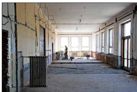
Bourací práce v DK skončily, pokračuje obnova elektroinstalace a vody
