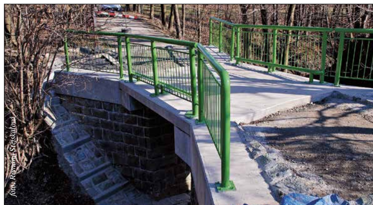
V dubnu bude dokončena rekonstrukce mostu přes Sadový potok
