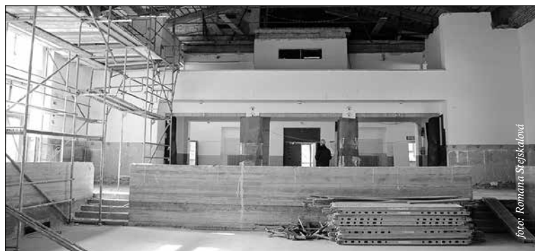
V Domě kultury probíhá montáž rozvodů vody, elektroinstalace a vzduchotechniky. V dubnu se bude odstraňovat střešní krytina.
