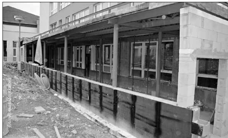
Dokončuje se stavba koridoru spojujícího školu se školní jídelnou a družinou
