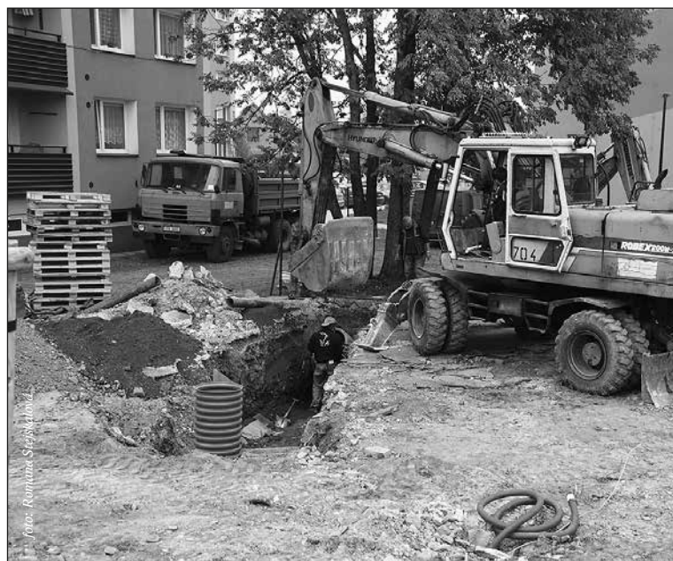
Pracovníci firmy COLAS CZ provádějí odvodnění parkovací plochy napojením na kanalizaci
