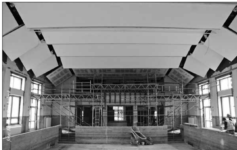
Ve velkém a malém sále jsou už namontovány akustické stropy
