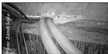
Hlavní 80 metrů dlouhé vedení přes půdu na jeviště
