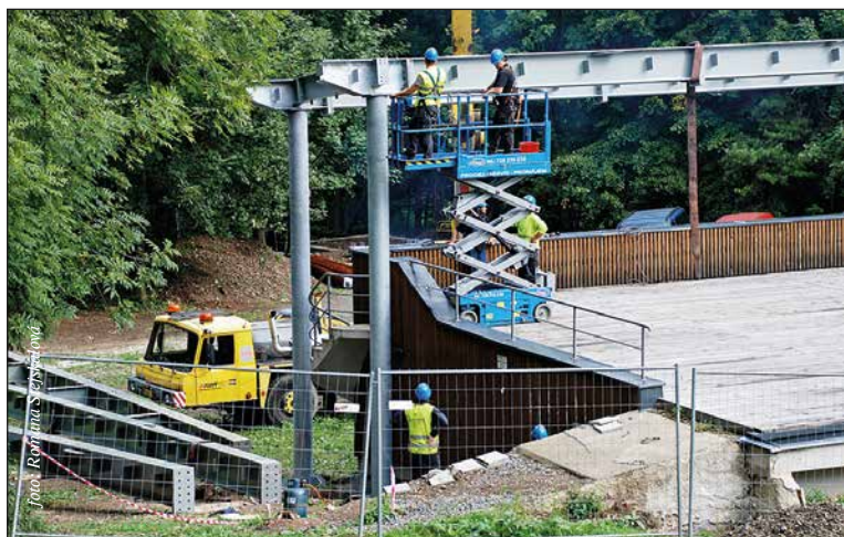
Konstrukce střechy pódia bude opláštěná dřevem
