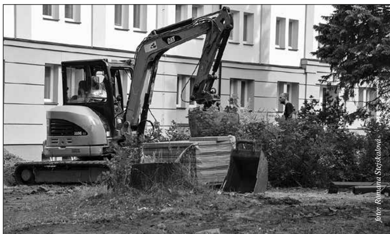
Bylo dokončeno odvodnění, kanalizace a terénní úpravy před školou
