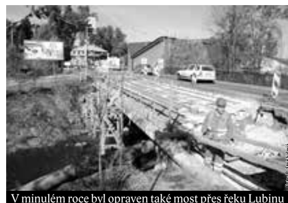
V minulém roce byl opraven také most přes řeku Lubinu
