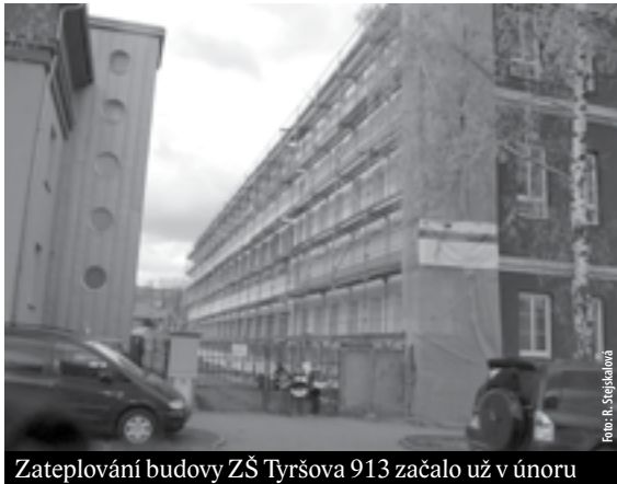
Zateplování budovy ZŠ Tyršova 913 začalo už v únoru
