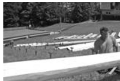
V polovině července ukončila firma Srub na instalaci hlediště amfiteátru na Hore 900 diváků
