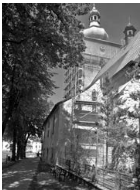
V červenci byla zahájena rekonstrukce horního kostela.
