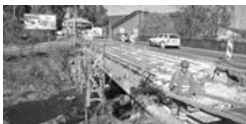
V červnu 2013 byla dokončena oprava mostu přes řeku Lubinu
