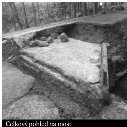
Celkový pohled na most
