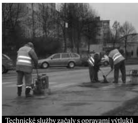
Technické služby začaly s opravami výtluků
