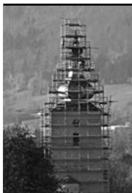
Oprava horního kostela potrvá do konce roku
