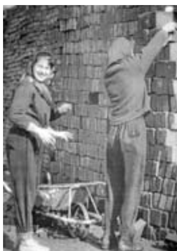
Práce žáků na výstavbě velké tělocvičny z let 1957–1965
