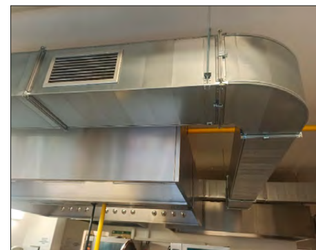
Výměna vzduchotechniky v mateřské školce
