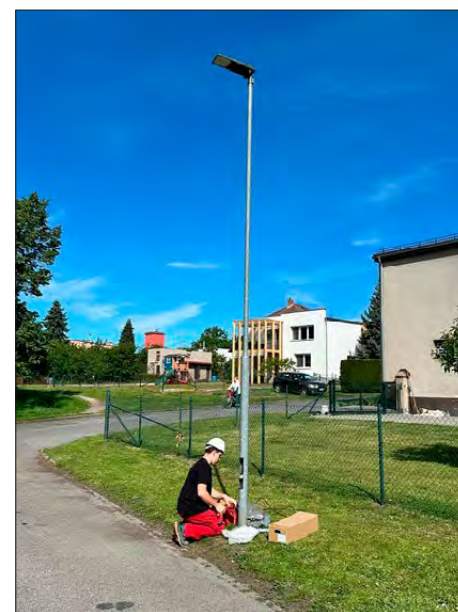
Výměna veřejného osvětlení
