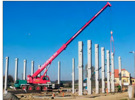
Výstavba tělocvičny Základní školy
