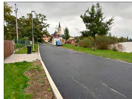
Rekonstrukce povrchu na ulici Podubí
