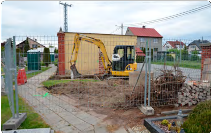
Stavební práce na hřbitově
