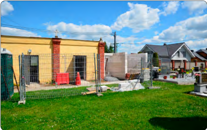
Stavební práce na hřbitově
