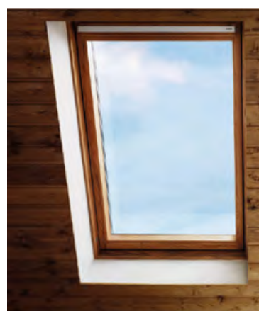
Výměna starého střešního okna za nové
