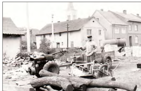
Stavba parčíku ke stolárně
