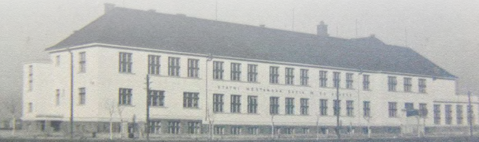
Nová školní budova v roce 1937
