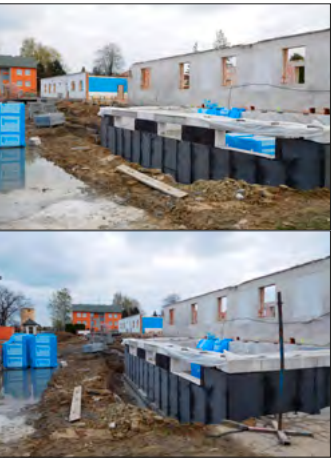
Máme vybetonováno Pomalou se to rýsuje
