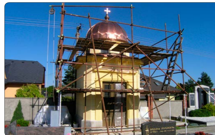
Oprava hřbitovní kaple 14. 9. 2016
