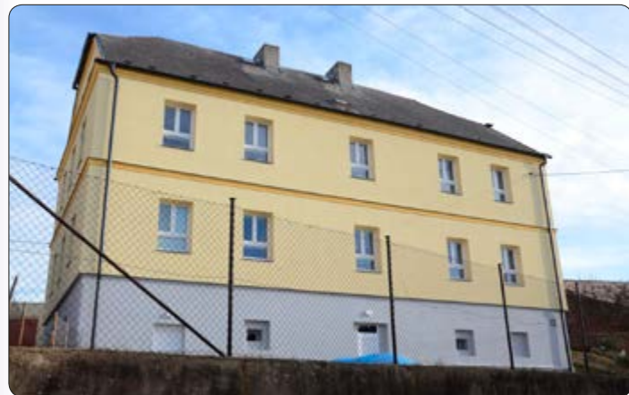
Opravená stará škola
