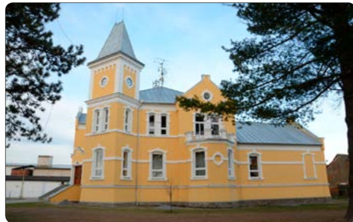
Opravená škola v Zábřehu
