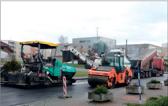
Oprava Opavská ulice.
