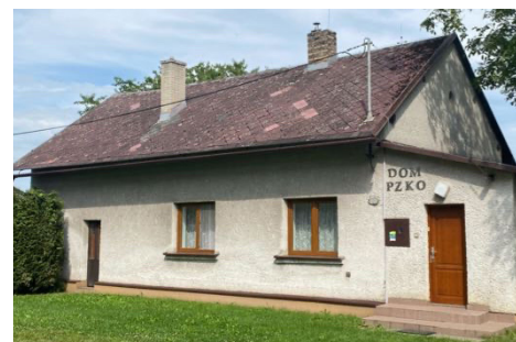
zdjęcie Domu PZKO przed rozpoczęciem remontu
