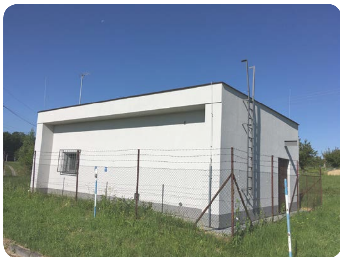
Opravená budova automatické tlakové stanice pro vodu
