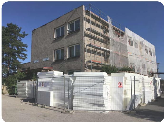
Demontáž střešky je za námi, bude se pokračovat se zateplením střešky a obálky
