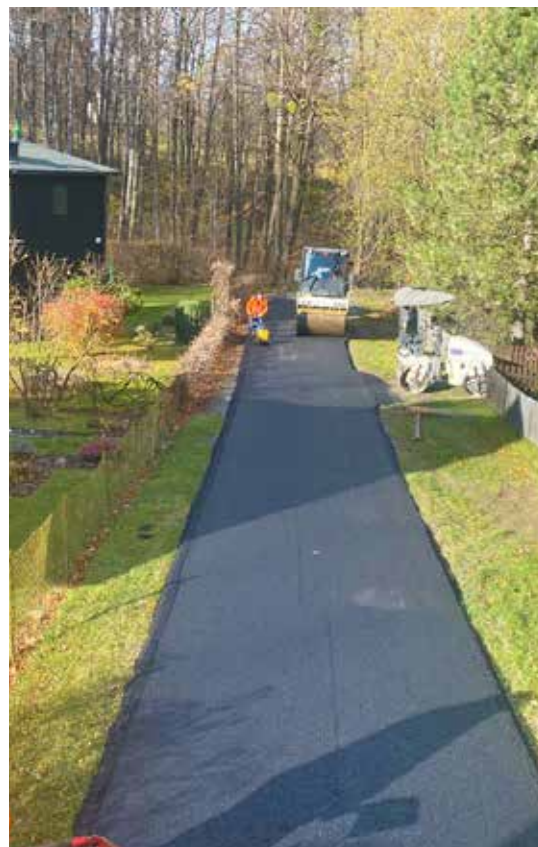
Pokládka povrchu v lokalitě Střelcovo
