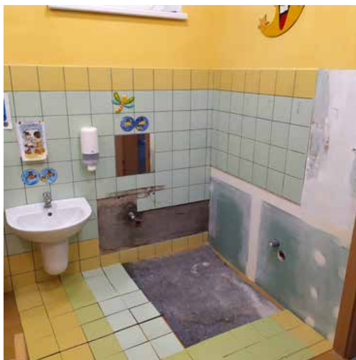
Koupelna dolní třídy už čeká jen na obložení a usazení umyvadla
