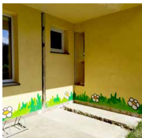
Příprava na vybudování toalety
