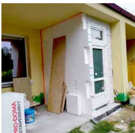
Toaleta během výstavby
