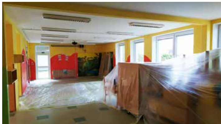
Všechno vybavení ve třídě jsme zabalili, aby se k němu nedostal prach z bouracích prací.
