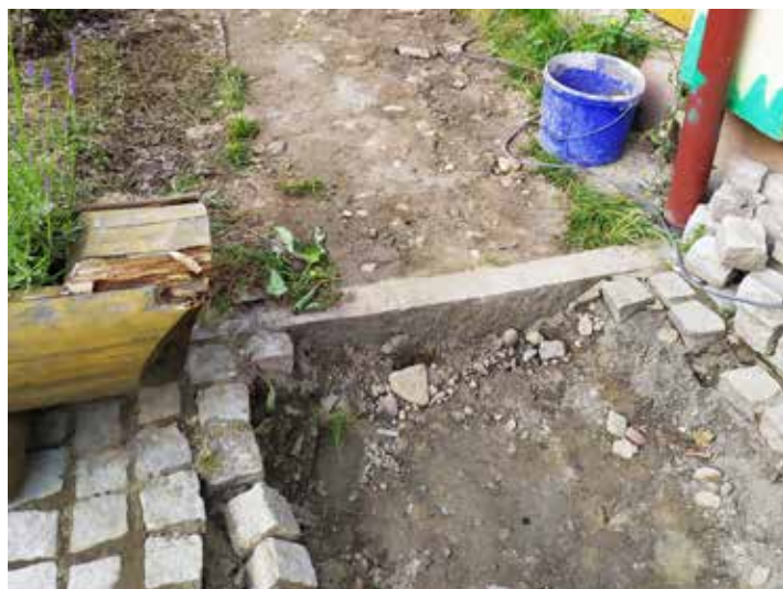
Aby se mohl vybudovat odpad pro budoucí toaletu, za své vzal na čas i chodník na zahradě.
