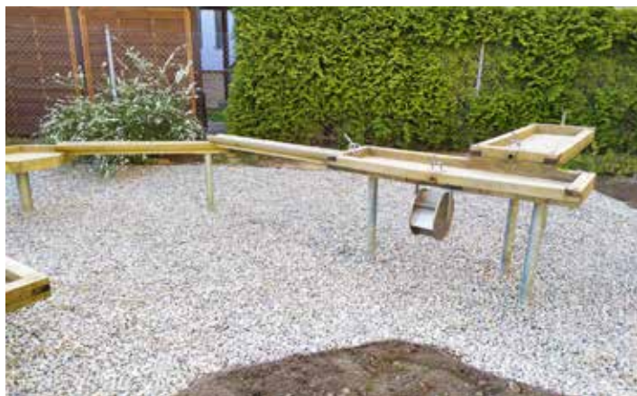
Písek pod vodními cestami, který bylo náročné udržovat podle hygienických předpisů, jsme nahradili kačírkem
