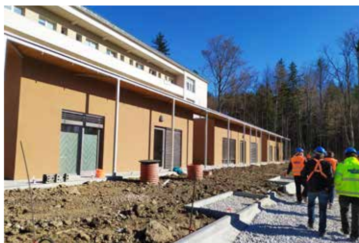
Nová rehabilitace již slouží pacientům ubytovaným v Léčebném domě dr. Storcha. Nyní se dokončují terénní úpravy, pamatováno je i na místa pro lavičky.
